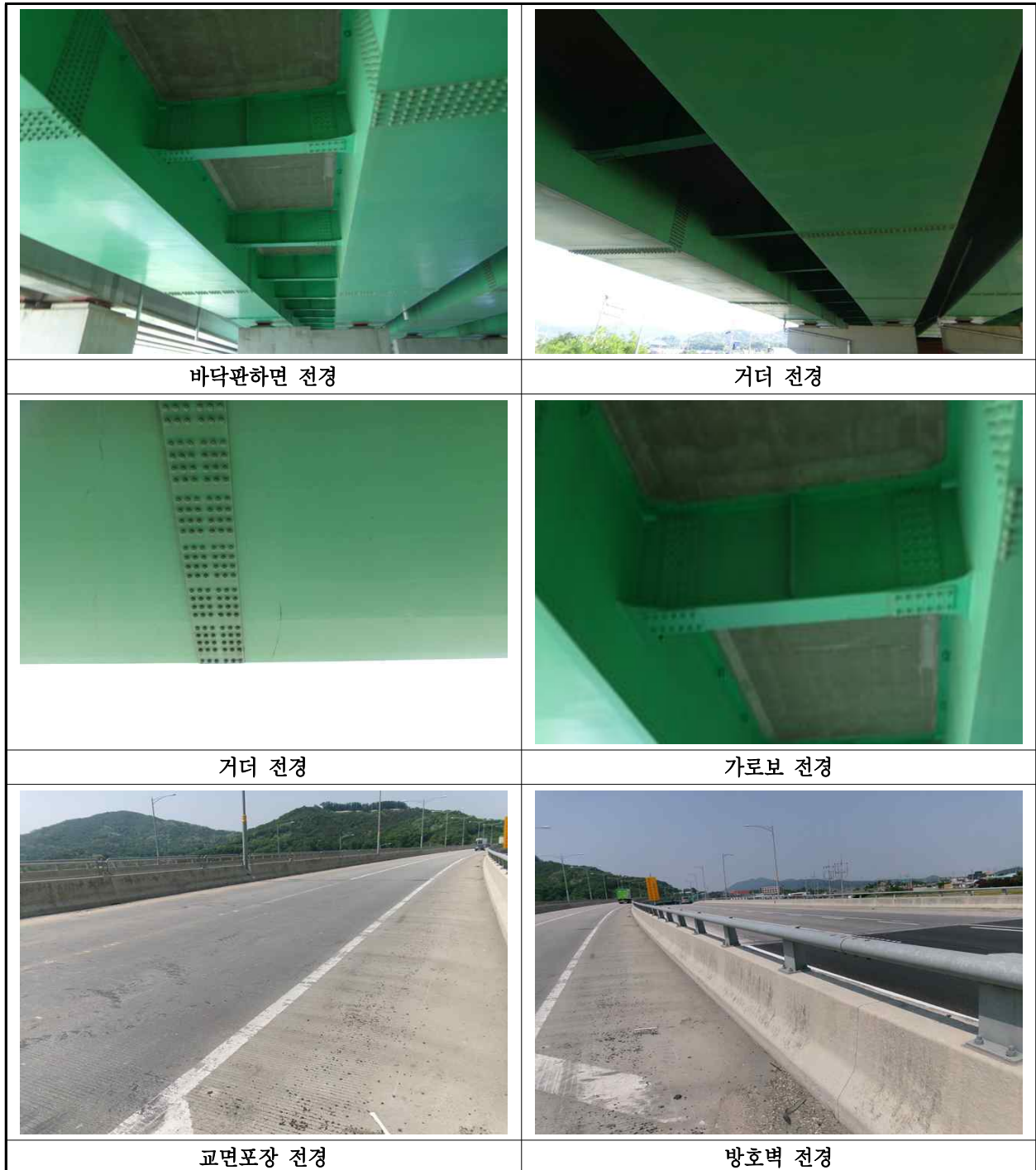
【사진 1.2.2】 상부구조 현황
