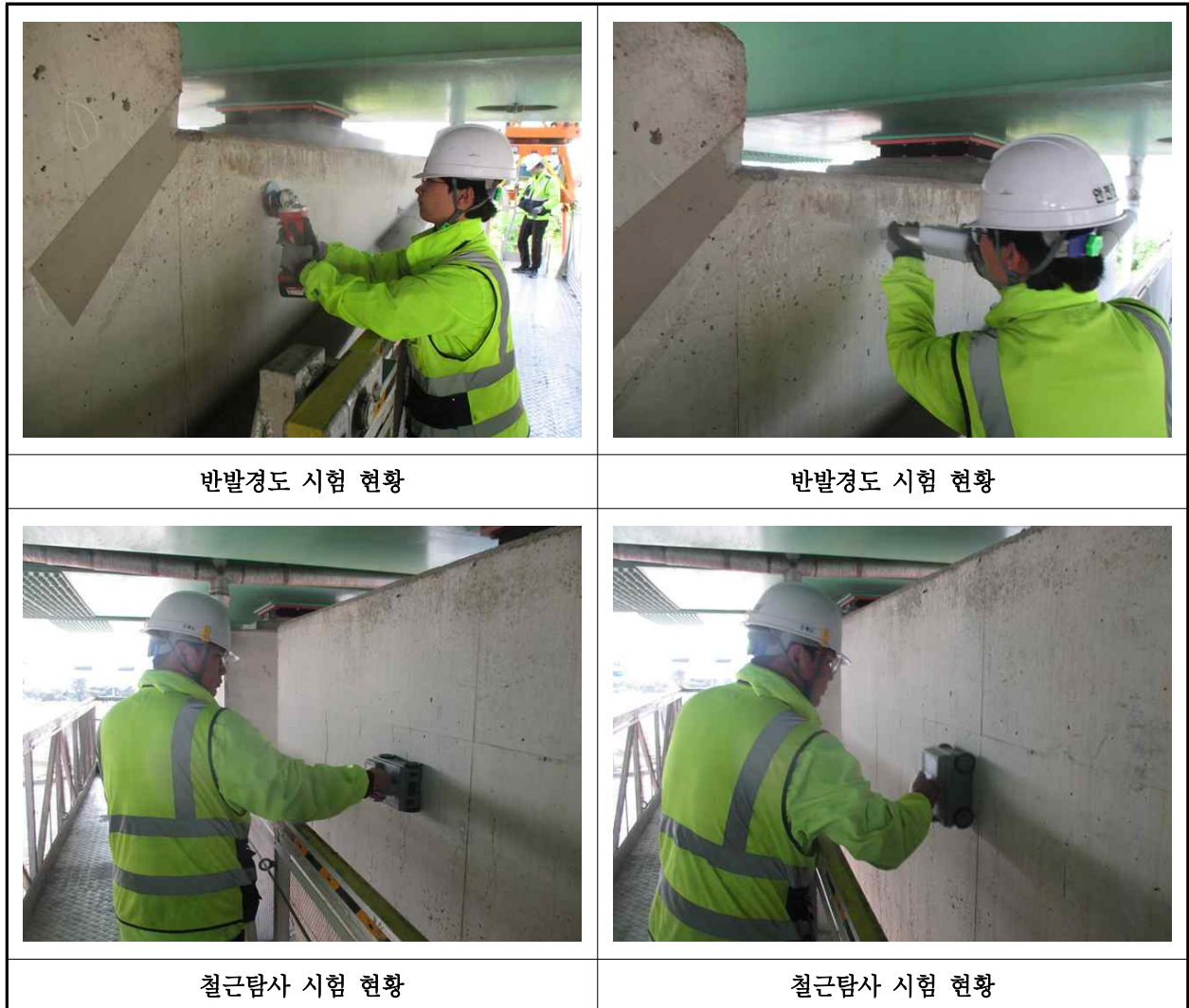
【사진 1.3.1】 콘크리트 내구성조사 현황
